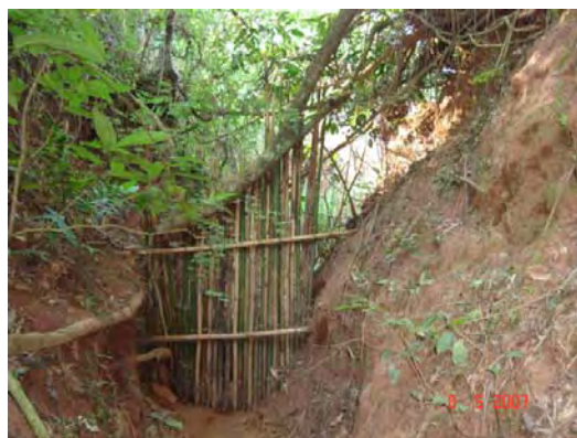
D. Paliçada como tentativa de controle de voçoroca atualmente.
