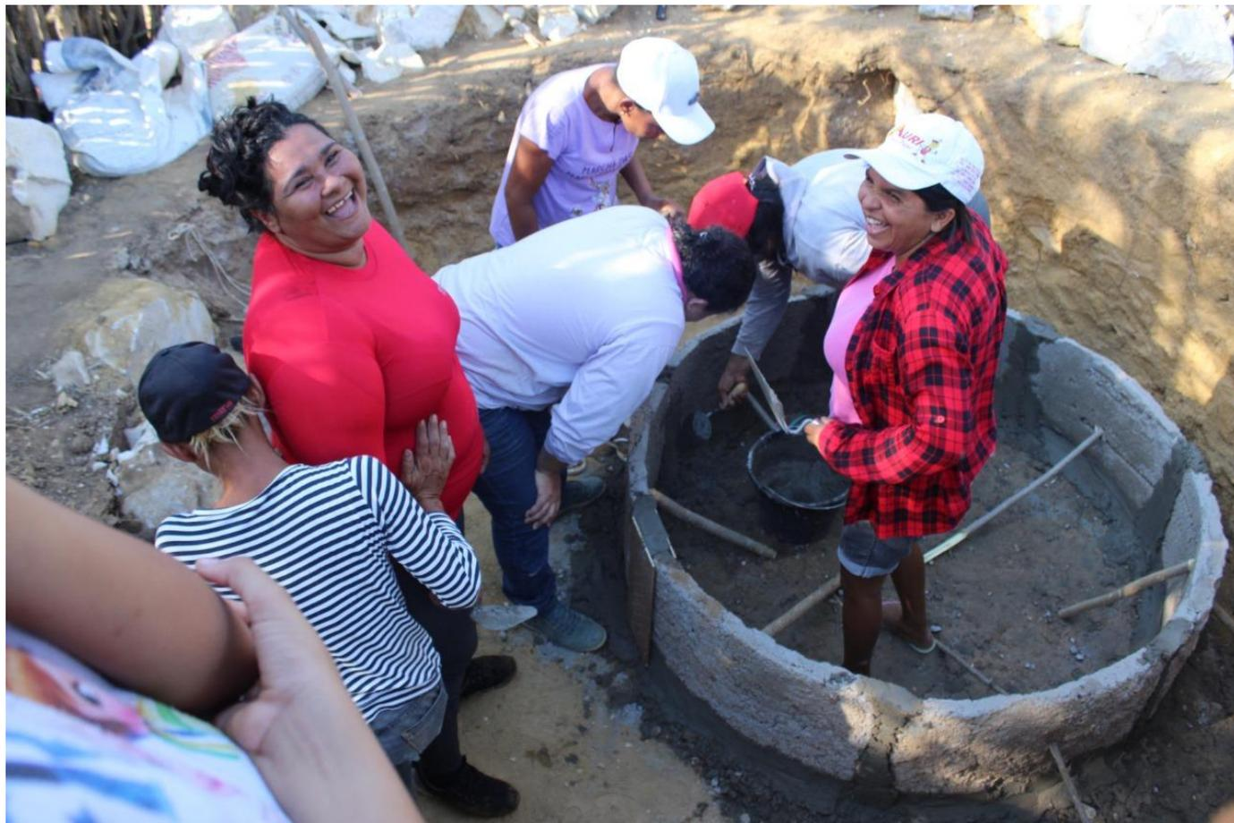
Figura 6 Mutirão para construção do filtro na casa de Ivonilda Oliveira. Fonte: Acervo CF8
