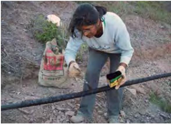
Protección del tramo expuesto de tubería en un cruce especial.
