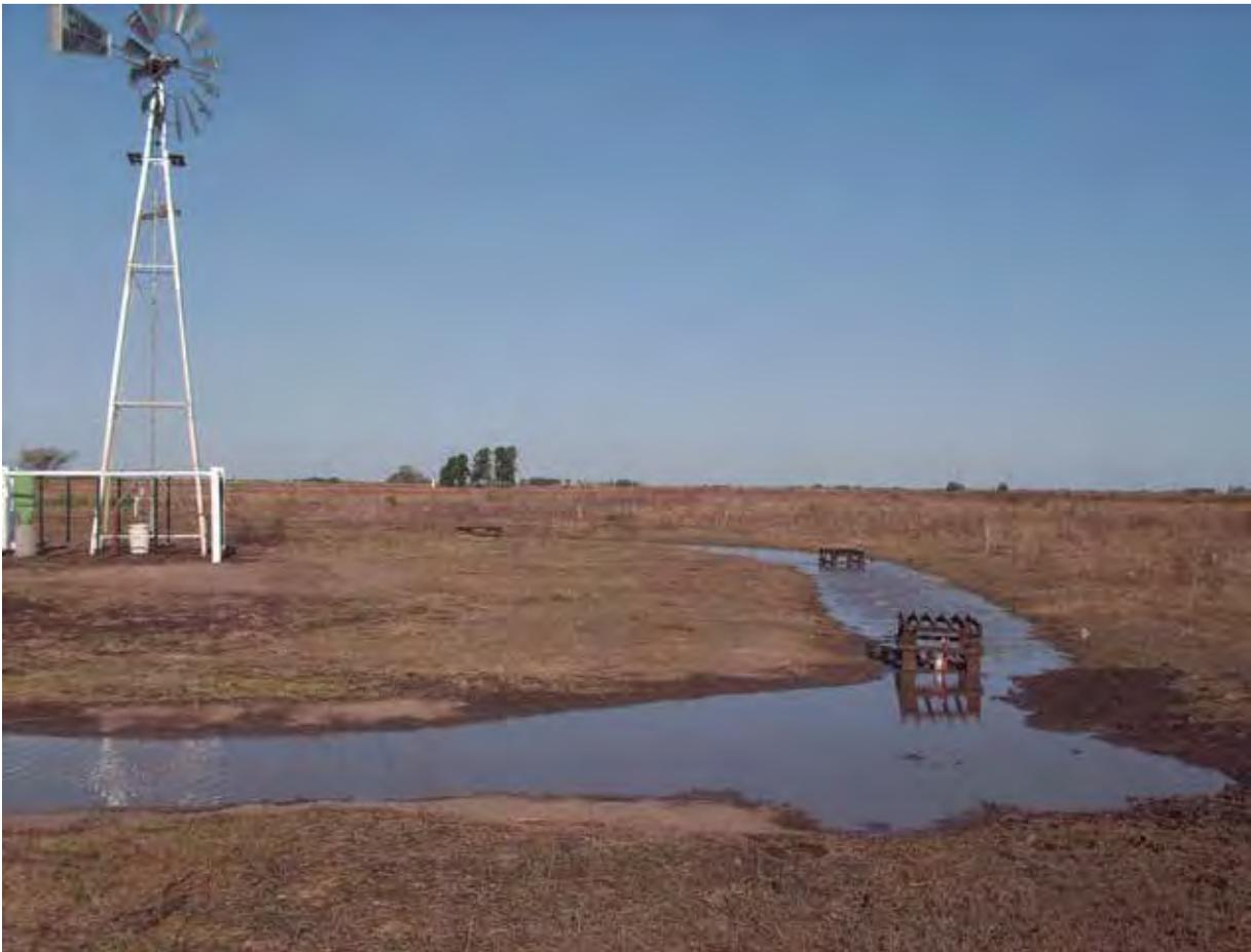
Sistema de recarga de acuíferos. La foto fue tomada después de una lluvia. Se aprecia la acumulación de agua y la recarga del acuífero inducida por la sistematización del terreno y realizada a través de los filtros de arena de las perforaciones doble propósito.
