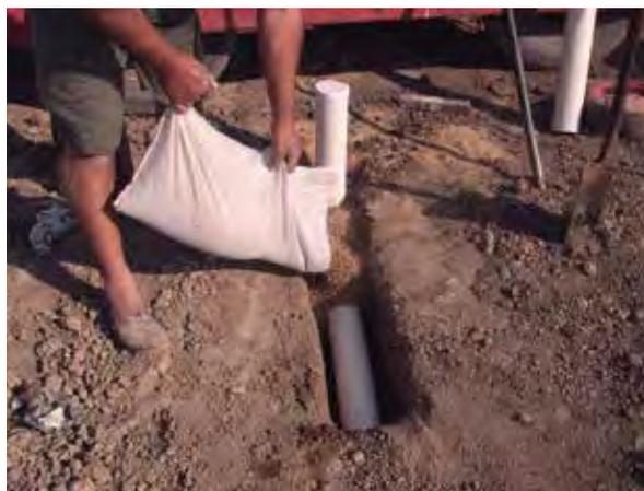
Agregado de grava alrededor del caño-filtro horizontal que se encuentra a 0,5 m de profundidad.
