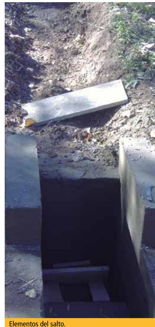
En general se construyen siguiendo el ancho del canal. La altura del muro o pared depende del desnivel que se quiera sortear hasta alcanzar la pendiente requerida. Precisan los mismos materiales del revestimiento y para su cálculo utilizamos las mismas proporciones.
