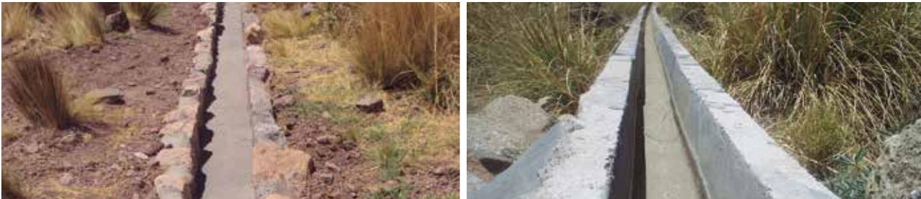
Canales revestidos en piedra calzada con junta de cemento y hormigón
