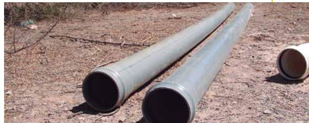
El tipo de unión dependerá del diámetro y presión nominal que deberán soportar los caños. En general las tuberías con diámetros chicos (hasta 3”) y que soportan presiones de hasta 4 kg/cm<sup>2</sup> se fabrican para unir mediante encolado (caso a).
