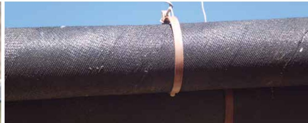
Protección de la tubería con tela media sombra y membrana asfáltica.
