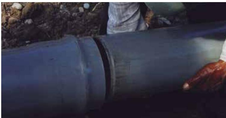
Tubería con extremos 'macho' y 'hembra'.
