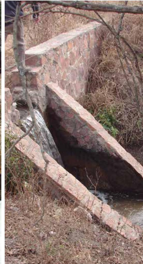
Mediante saltos podemos resolver cambios en la pendiente o mantener la pendiente de diseño.
