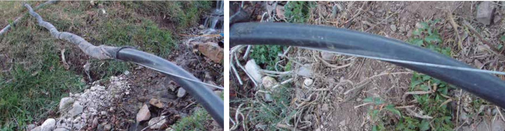
En puentes cortos el alambre se enrosca sobre la tubería y luego se tensa.
