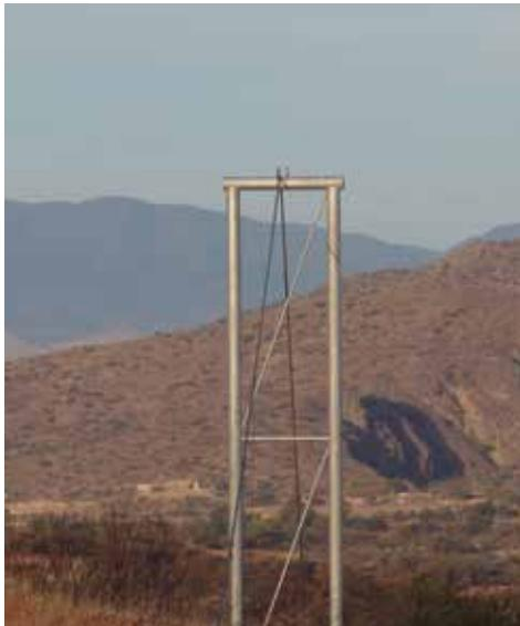
Columnas realizadas con tubos galvanizados.
