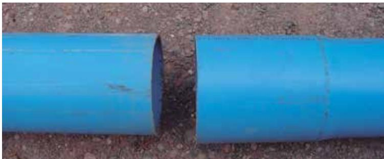
Unión de tuberías mediante adhesivos.
