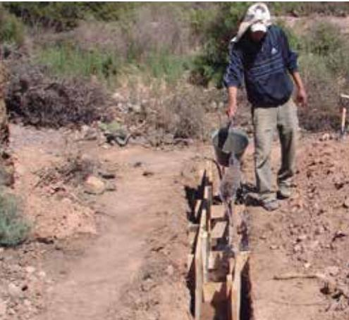
Armado y humedecimiento del encofrado.
