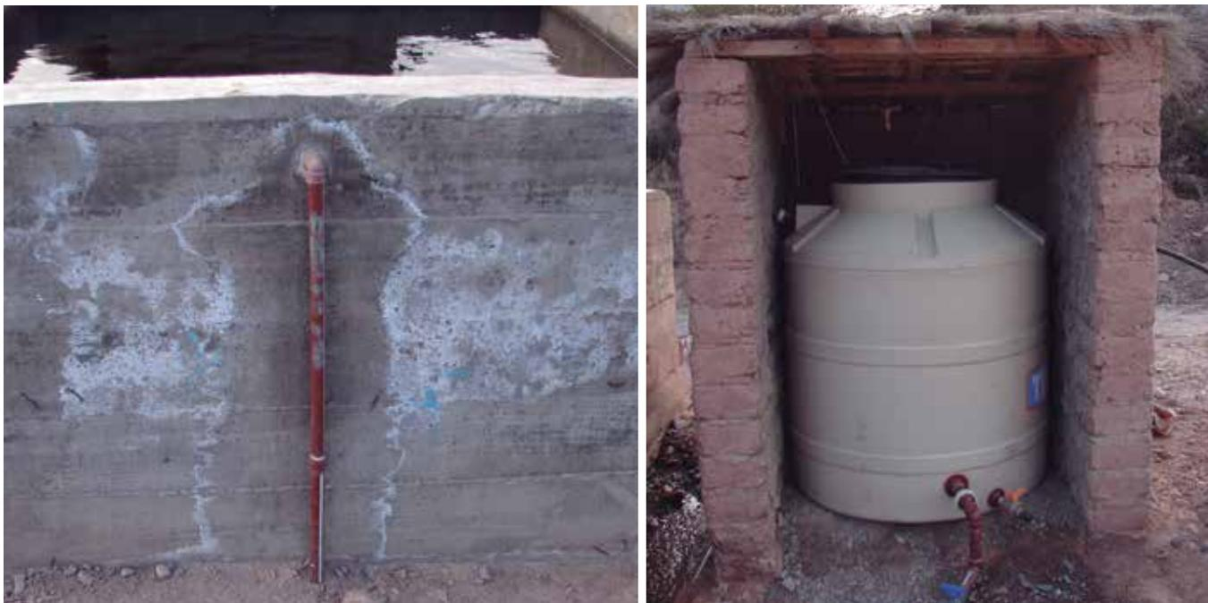
Tuberías de polipropileno en cisternas.
