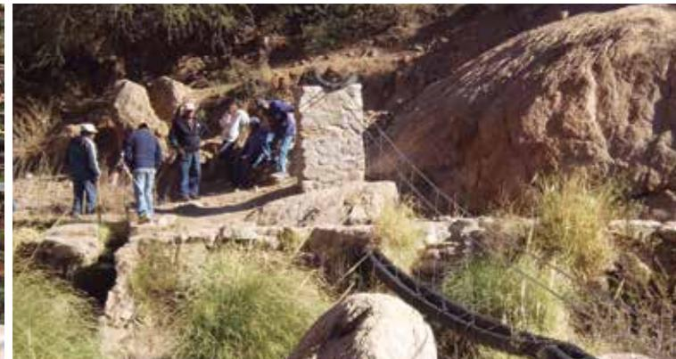
» **Flecha del puente:** Es la distancia que existe entre la horizontal que determinan los postes y el punto más bajo del cable (generalmente el punto medio).
