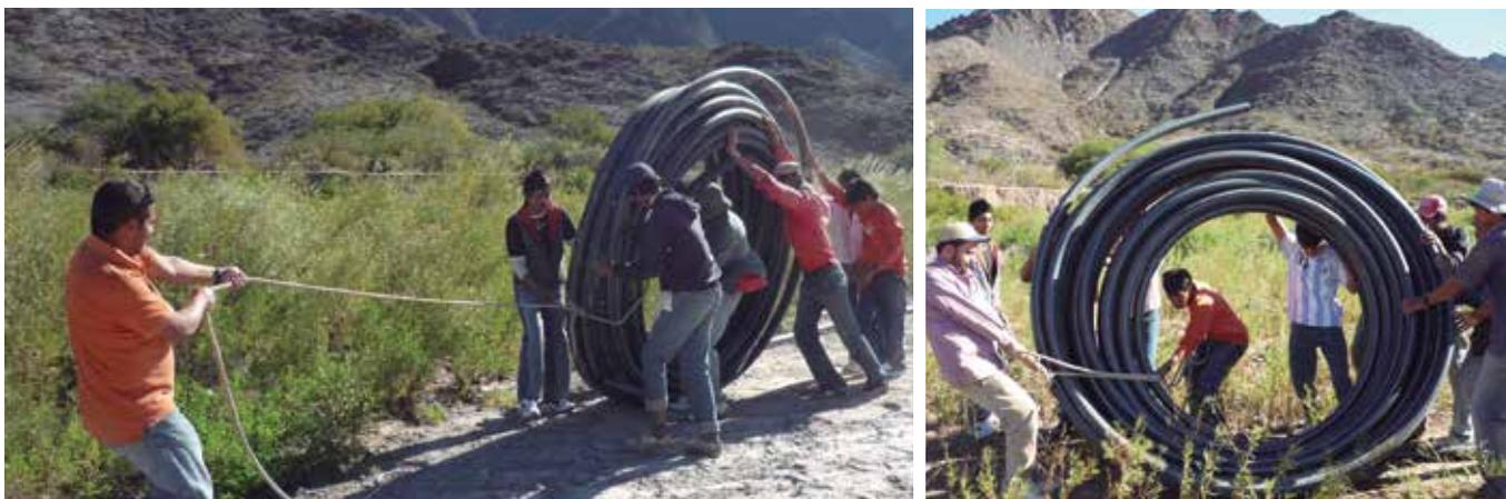
Desenrollado mediante una soga para evitar la formación de espirales que produzcan quiebres en la tubería. Comunidad El Churcal, Salta.
