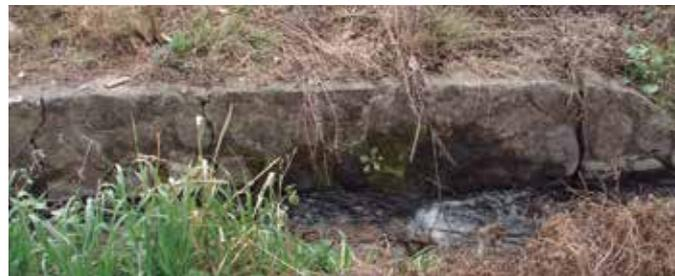
Roturas en el canal donde se produce infiltración y que con el tiempo pueden originar asentamientos y mayores roturas.
