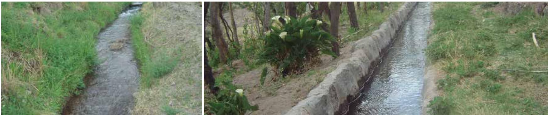
Para una misma sección o tamaño de canal, la velocidad es mayor en canales revestidos, por lo tanto transportan un mayor caudal de agua, logrando mejor eficiencia.
