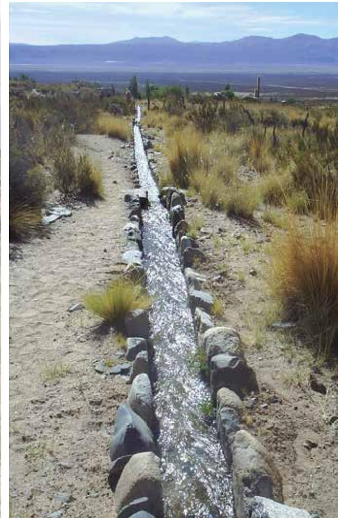
Impermeabilización de acequias mediante piedra calzada y junta de cemento.
