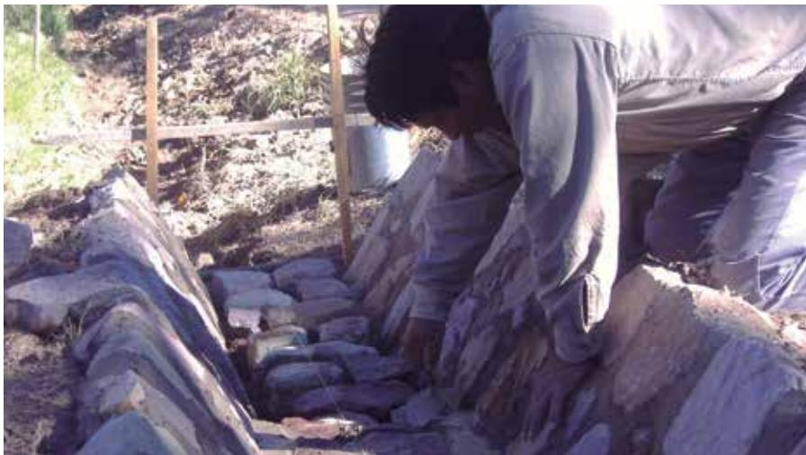
Canal con talud inclinado o sección trapezoidal.
