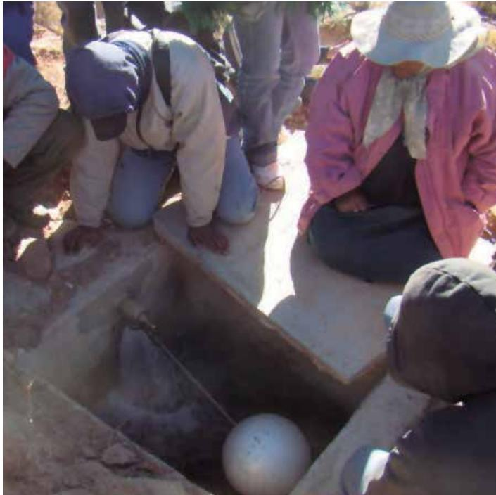
Cámara rompecarga y flotante de alta presión. Urcuro, Salta.
