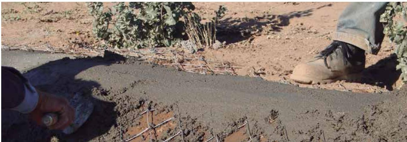
Revestimiento con ferrocemento.
