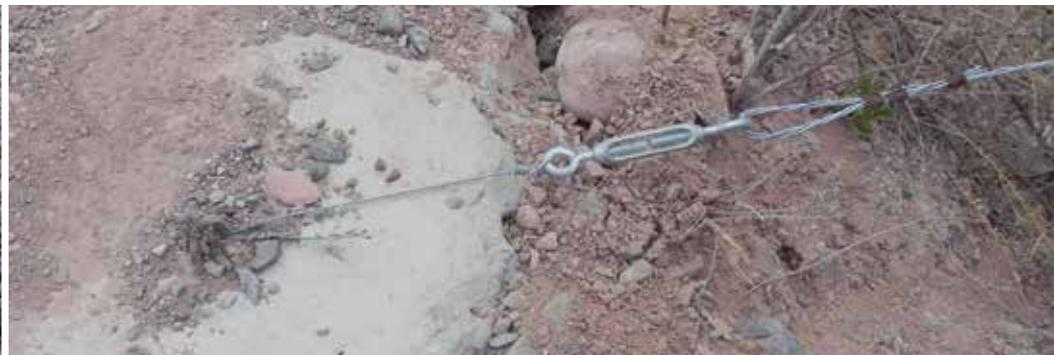
Anclajes y tensores en puentes simples.
