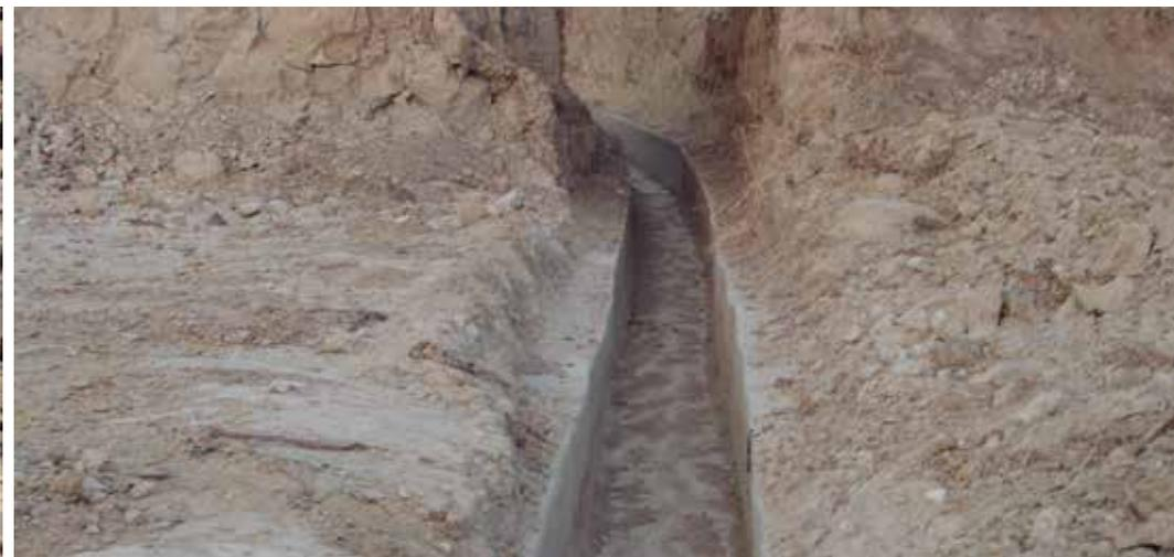
El encofrado se puede realizar en ambas caras. La situación más común y más fácil es encofrar sólo del lado interno, usando el suelo como contención del lado externo.
