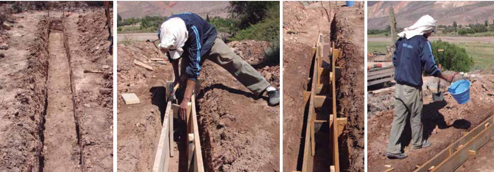
Encofrado de la excavación.
