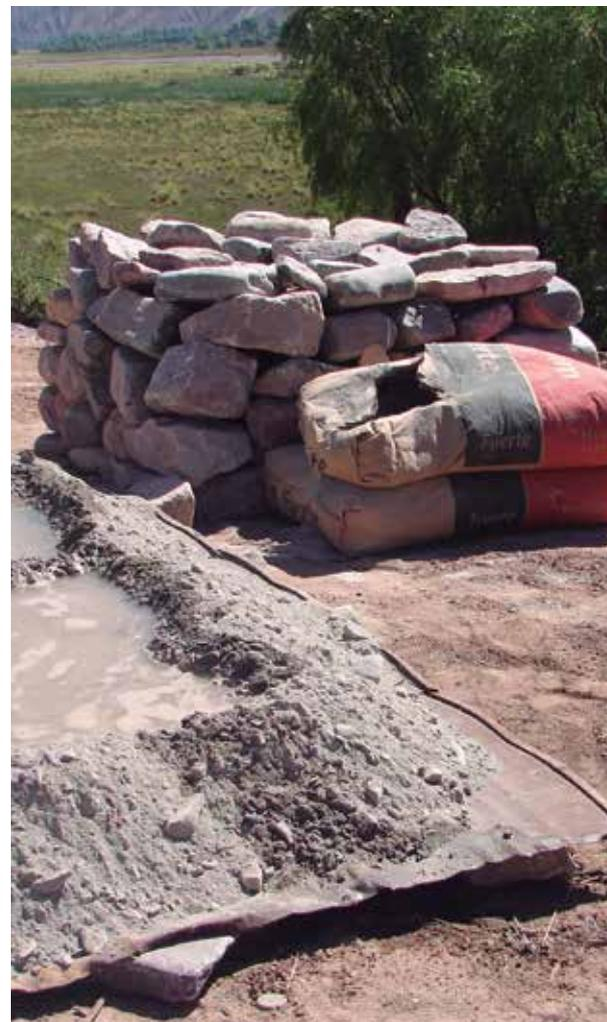
Preparación del concreto o mortero.
