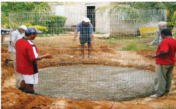
Figura 24. Cisterna de alambrado
