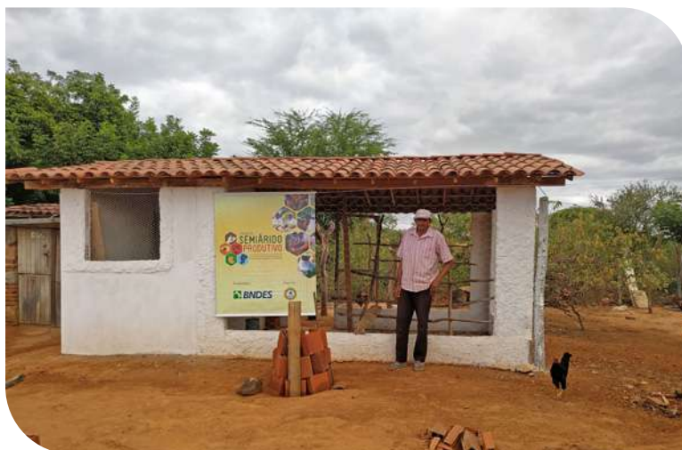
Galinheiro construído na UPF de Francisco Batista, na comunidade Bom Lugar, em Bodocó - PE.
