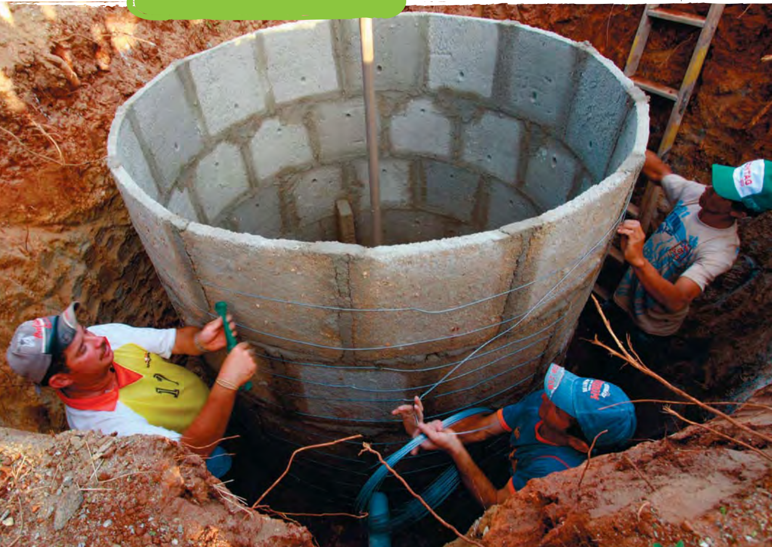
[Figura 14] Amarração da parede com arame galvanizado
